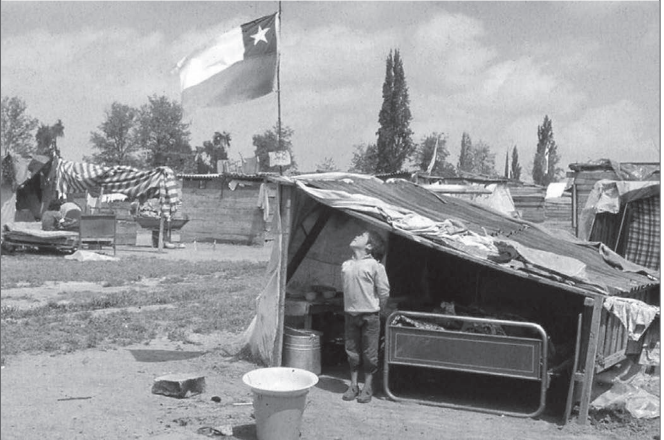
Toma de terreno Campamento Nueva la HABANA, 1970
