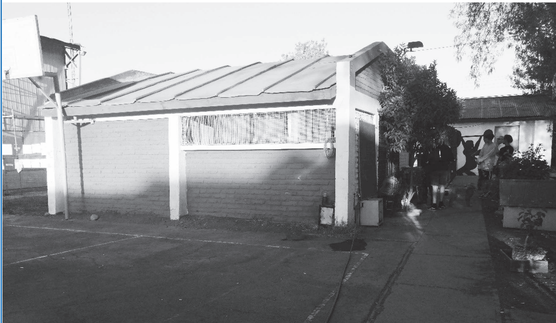
Sede vecinal Villa Ecuador, ubicada al medio del terreno que comprende las sedes sociales, el gimnasio y la cancha de fútbol
